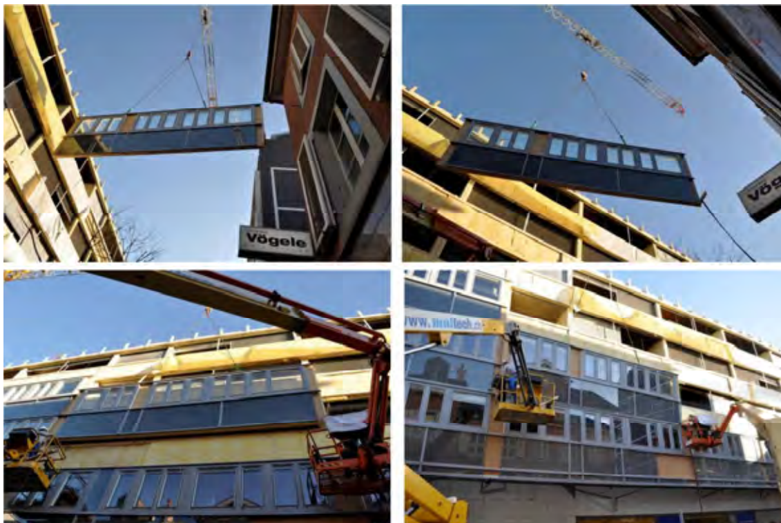
Figure 5 : Eléments préfabriqués mis en applique sur la façade existante
