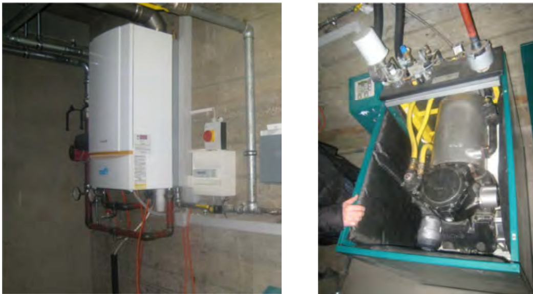
Figure 13 : Chaudière (photo de gauche) et groupe chaleur force (photo de droite)
